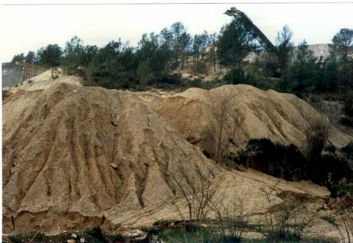
Foto nº 7. Detalle del acarcavamiento en la estructura 34-17-1-3.
