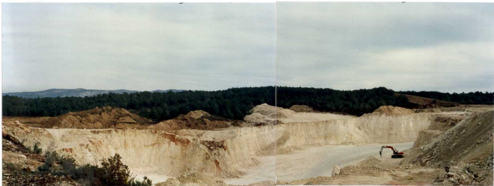
Foto nº 3. Vista de la explotación, y algunas estructuras asociadas, de creta de Clarianacal S.A. en los términos de Arbós (Tarragona) y Castellet (Barcelona).
