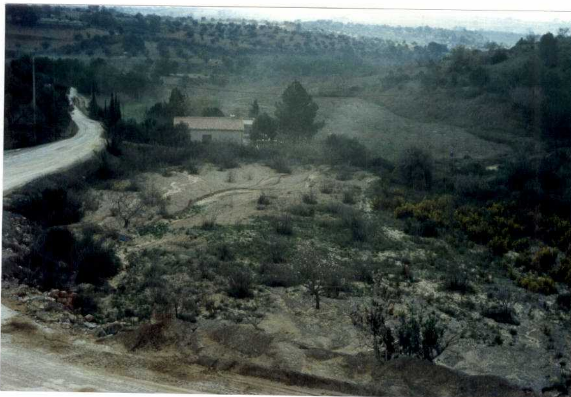
Foto nº 8. Los materiales erosionados de la estructura 34-17-1-3 invaden los terrenos próximos.
