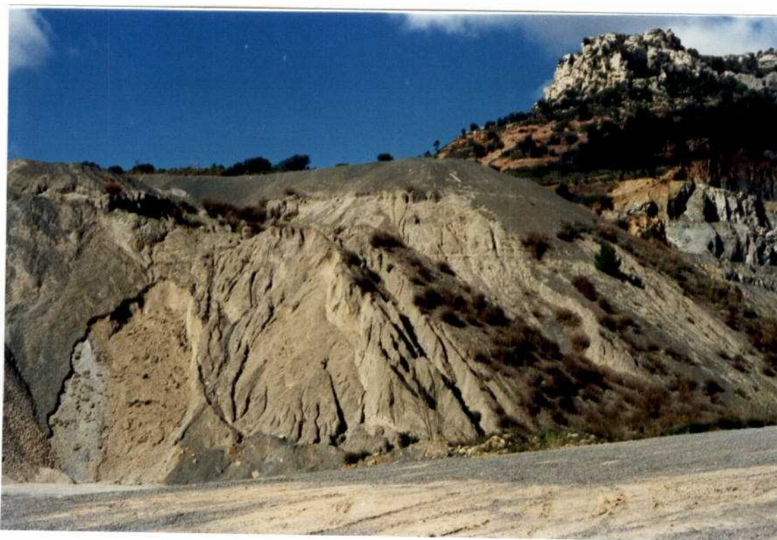
Foto nº 9. Detalle de erosión y deslizamiento en la estructura 33-17-6-2, constituida por un antiguo stock de arenas y gravas de cuarcita.
